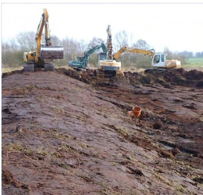
Abb. 2: Bau einer Torfdichtwand Foto Bretschneider
